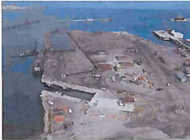
Lavori per la costruzione del terminal Apm a Vado Ligure
